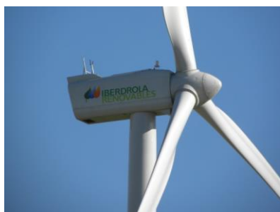
Parc éolien de Nurlu 3
